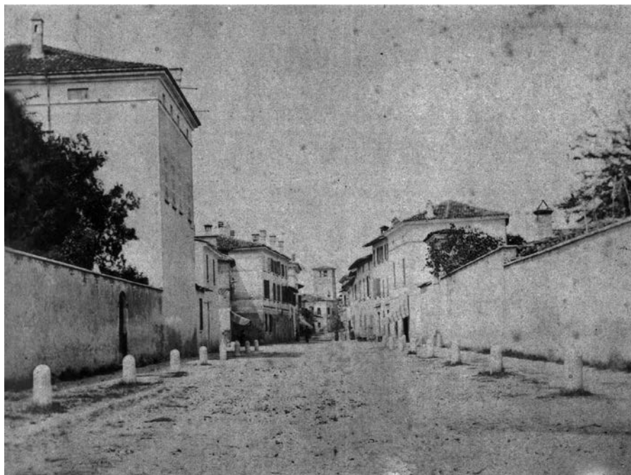
Foto n. 1. Con alle spalle il viale Passeggio, si vede tutta la via del Municipio fino alla torre mozza dopo il suo crollo. Siamo prima del 1901. Si notino i paracarri (?), i tanti camini sui tetti ed un lampione a gas sulla sinistra (cartolina)
