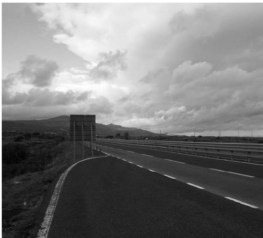
Fig. 1 – Il paesaggio delle infrastrutture: la SS131 “Carlo Felice”
