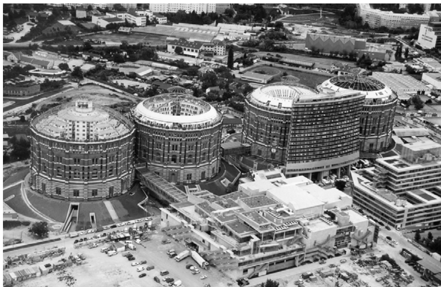
Fig. 6. Il progetto ai gasometri di Vienna prevedeva la realizzazione di un complesso multifunzionale comprendente residenze, uffici, spazi per il commercio e l'intrattenimento conservando l'immagine del vecchio insediamento industriale. (credits Thomas Krüger)
