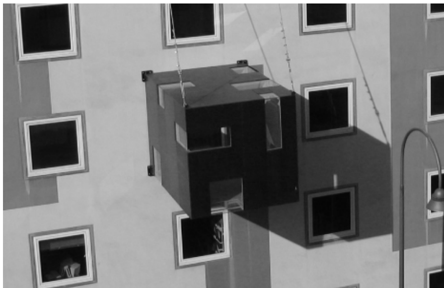
Fig. 7. Rucksack house, Il progetto rientra in quella categoria conosciuta come 'architettura parassita', categoria di piccole architetture che utilizzano l'esistente come struttura che consente loro di esistere.(credits Claus Bach)
