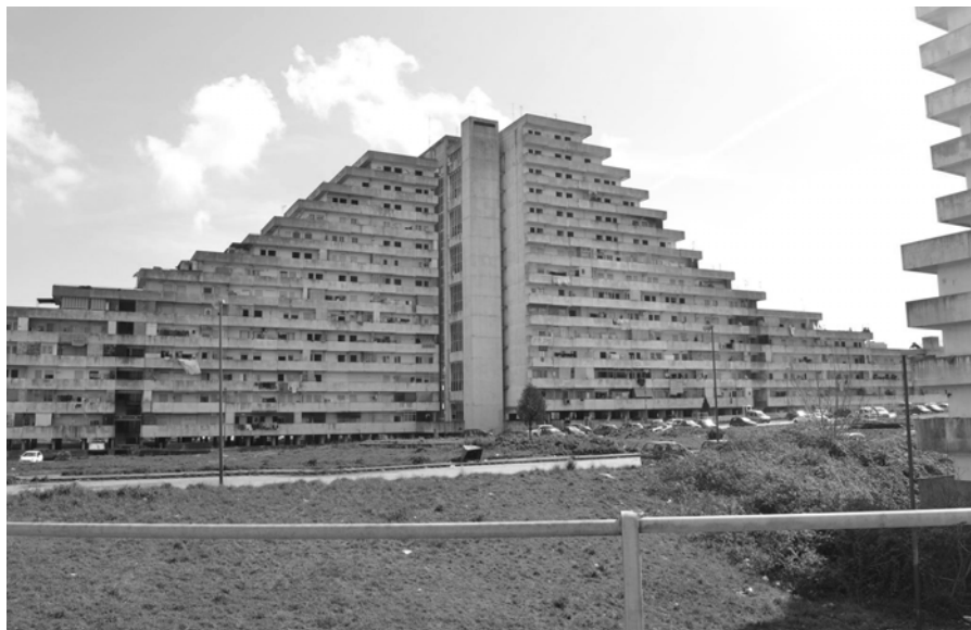
Fig.5. Le Vele di Scampia, costruite nell'omonimo quartiere della città di Napoli tra il 1962 e il 1975, sono state realizzate tenendo in poco conto il progetto originario per motivi di velocità ed economia. Questo ha portato ad un rapido decadimento, sia architettonico sia sociale (credits Raffaella Sessa)
