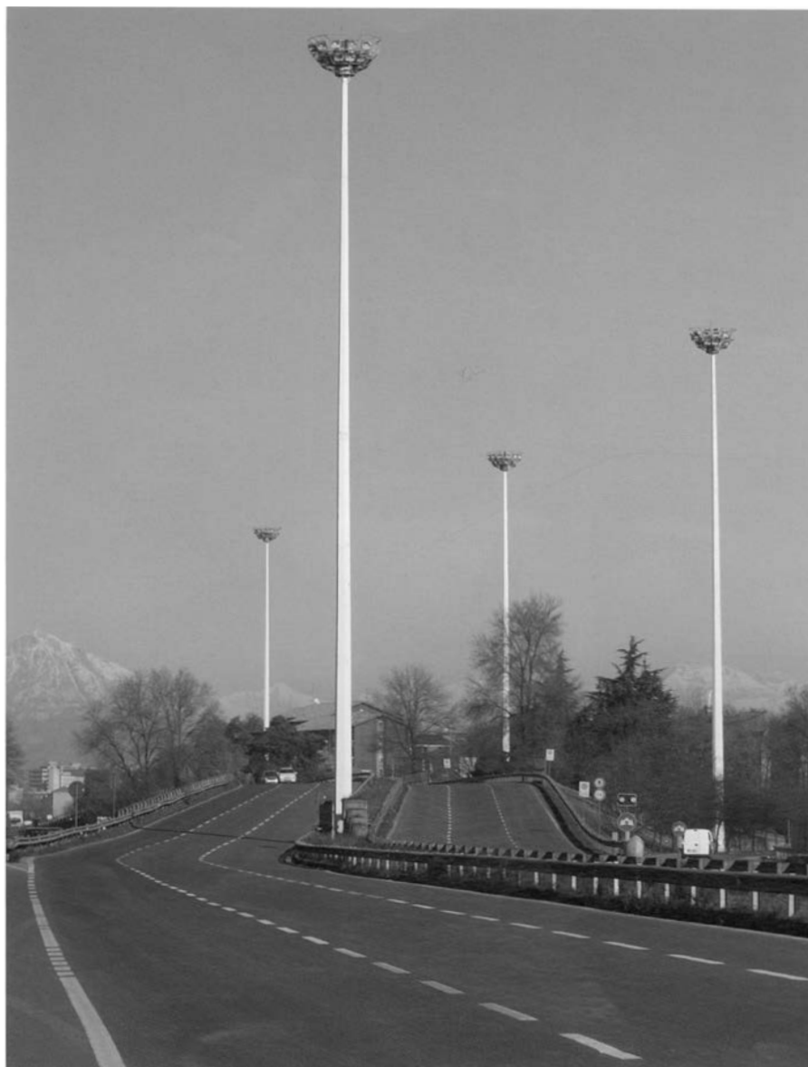
Fig. 1 - In figura quattro torri-faro in lamiera d'acciaio presso-piegata ed elettrosaldata. Particolare torre-faro (altezza 42 m f.t.). Piattaforma circolare ascendente-discendente-discendente con corpi illuminanti
