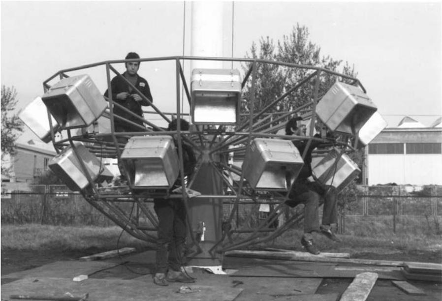
In fig. 2a,b, la piattaforma ascendente-discendente delle torri-faro rappresentate in fig. 1 e verniciate con vernice epossidica bianca durante la fase di montaggio.
