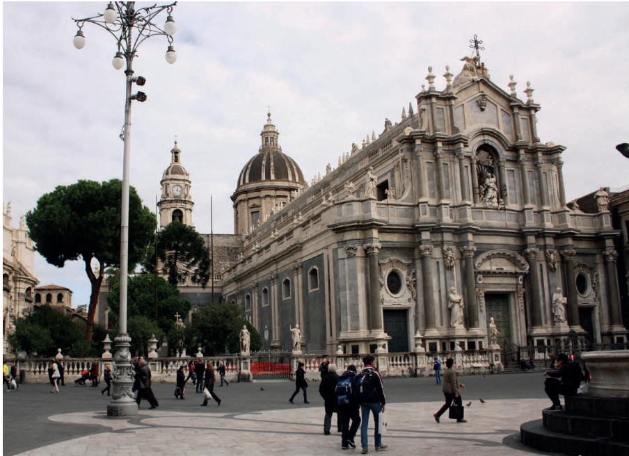
Cattedrale di Catania, facciata e prospetto settentrionale
