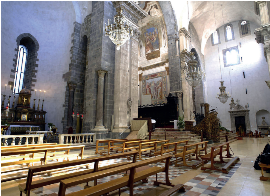
Transetto e absidi (veduta da nord)
