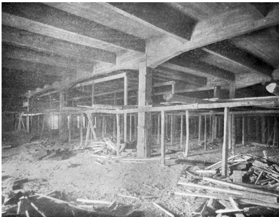
Figg. 1-2 – Il magazzino militare di la Spezia (1916-17), veduta prospettica del progetto (in alto) e veduta dell'interno dell'edificio in cantiere (in basso). Il frigorifero costituì uno dei primi esempi di edificio costruito interamente in calcestruzzo armato con rivestimenti interni in lastre di sughero a doppio strato da 12-16 cm.
