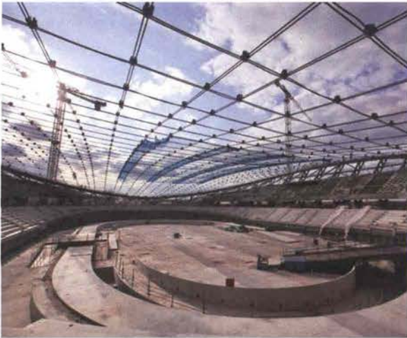
Il velodromo di Londra 2012 durante e dopo i lavori, la tensostruttura in acciaio a rete di funi consente di smaterializzare la copertura, con notevole risparmio di materiali anche per le altre strutture portanti. ©Olympic Delivery Authority
