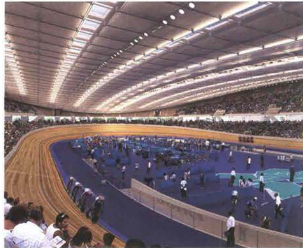
Il velodromo di Londra 2012 durante e dopo i lavori, la tensostruttura in acciaio a rete di funi consente di smaterializzare la copertura, con notevole risparmio di materiali anche per le altre strutture portanti. ©Olympic Delivery Authority
