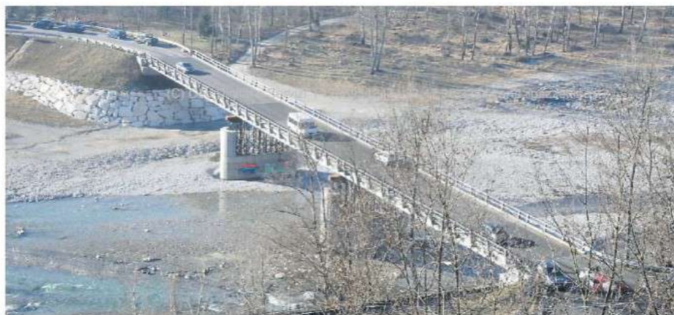
A LAMBOI il ponte Bailey, installato nel 2007 come struttura provvisoria, è stato prorogato a tutto il 2027
